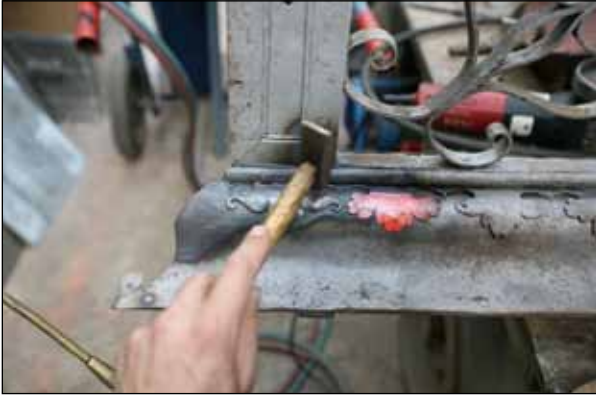
Abb. 5 Weimar, Stadtkirche, Arbeitsansicht während der Ergänzung fehlender Zierelemente auf den Metallgittern, 2010
